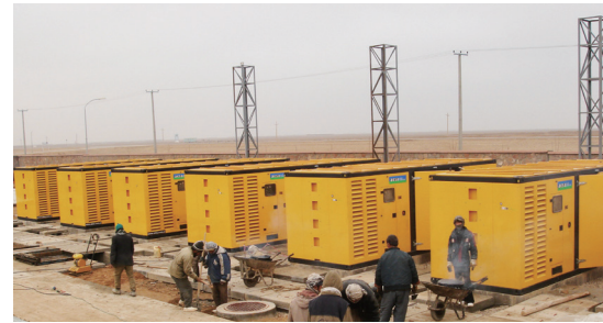
La compañía nacional argelina de electricidad, 20 unidades de contenedores( 880KVA, 10KV) de grupos electrógenos de alto voltaje de puesta en paralelo.
