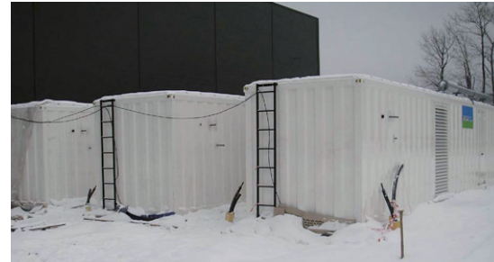
La fábrica de PVC RUIHAO de Moscú, 3 unidades de contenedores( 2250KVA, 400V) de grupos electrógenos de alto voltaje de puesta en paralelo.
