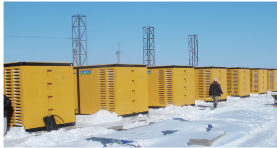
La compañía nacional argelina de electricidad, 20 unidades de contenedores( 880KVA, 10KV) de grupos electrógenos de alto voltaje de puesta en paralelo.
