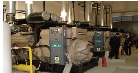
El aeropuerto internacional de Istanbul, 5 unidades de contenedores( 2000KVA, 6.3KV) de grupos electrógenos de alto voltaje de puesta en paralelo.
