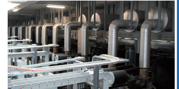
El supermercado de Tesco de Inglaterra. 31 unidades de grupos electrógenos, potencia es 650KVA~1435KVA, capacidad total es 34065KVA.
