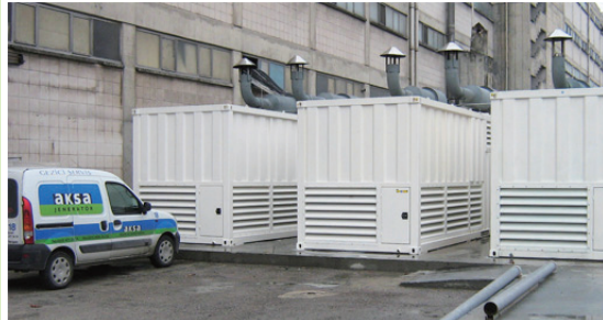
La fábrica de PVC RUIHAO de Moscú, 3 unidades de contenedores( 2250KVA, 400V) de grupos electrógenos de alto voltaje de puesta en paralelo.
